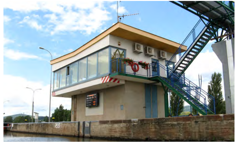
Schmuckes Schleusenwärterhäuschen in České Kopisti
