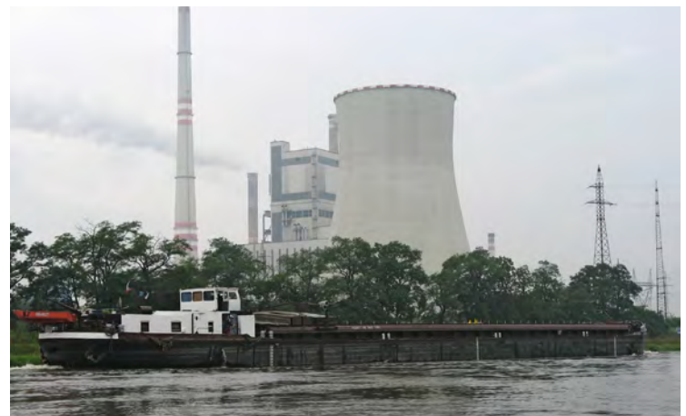
Braunkohlekraftwerk am Ufer; 10 km nordwestlich von Mělník
